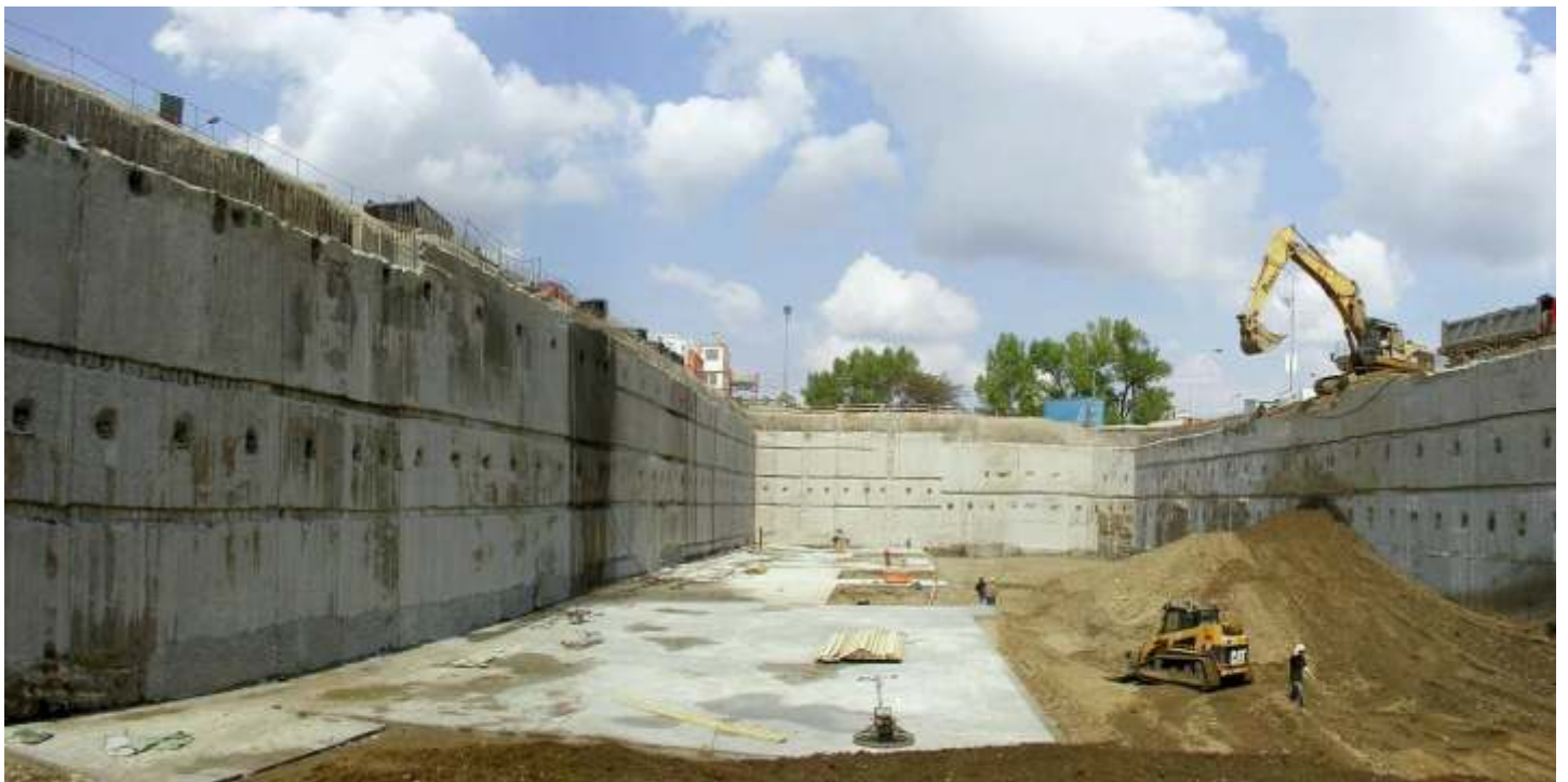
Ukončení speciálního založení stavby a zahájení prací na základové desce hloubka stavební jámy je 13,7 m pod terén
