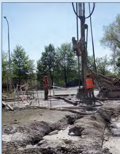
SO 10, opatření 103, provádění TI
