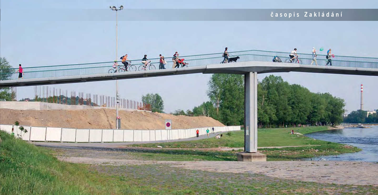
SO 50, opatření 501, výstavba PPO s pohledem na lávku na Císařský ostrov
