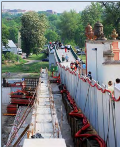
SO 50, opatření 504, příprava pro montáž kotvení mobilního hrazení
