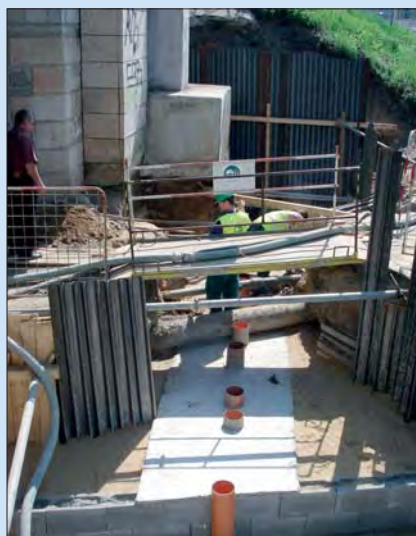
SO 60, podjezd ČD Pod Paťankou, základová spára s přípravou pro TI
