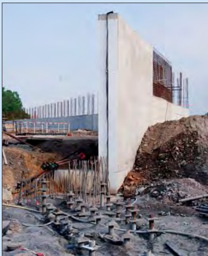
SO 50, opatření 502, místo budoucího dosedacího prahu pro mobilní hrazení, kotveného MP v místě křížení s komunikací
