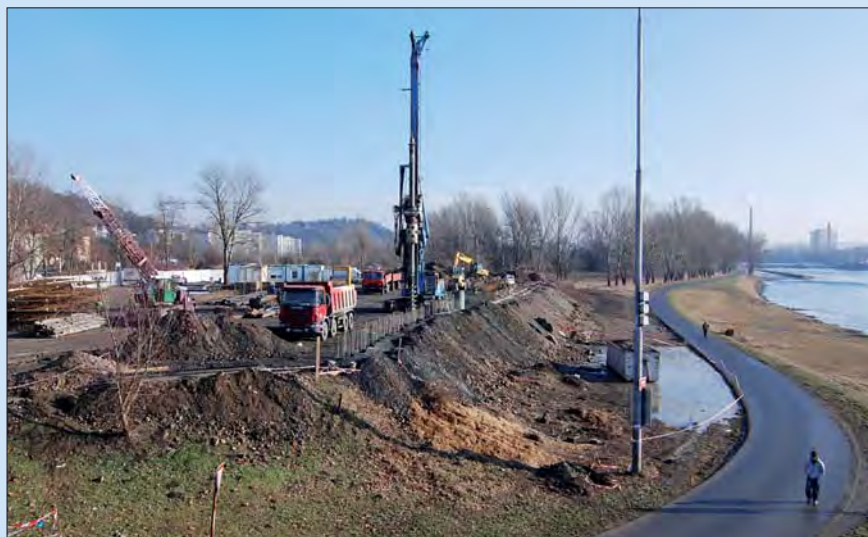
SO 50, opatření 501, provádění převrtávané pilotové stěny
