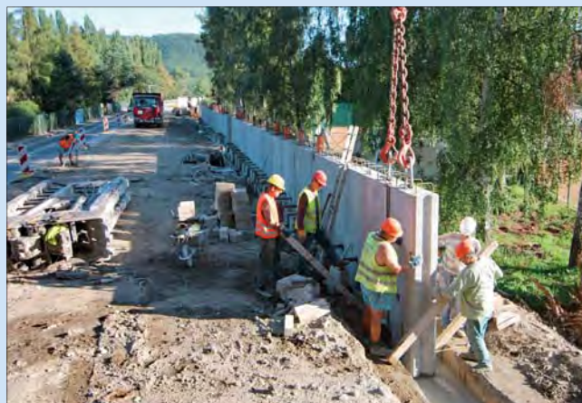
Přesné osazování panelu podzemní stěny do předtěžené rýhy
