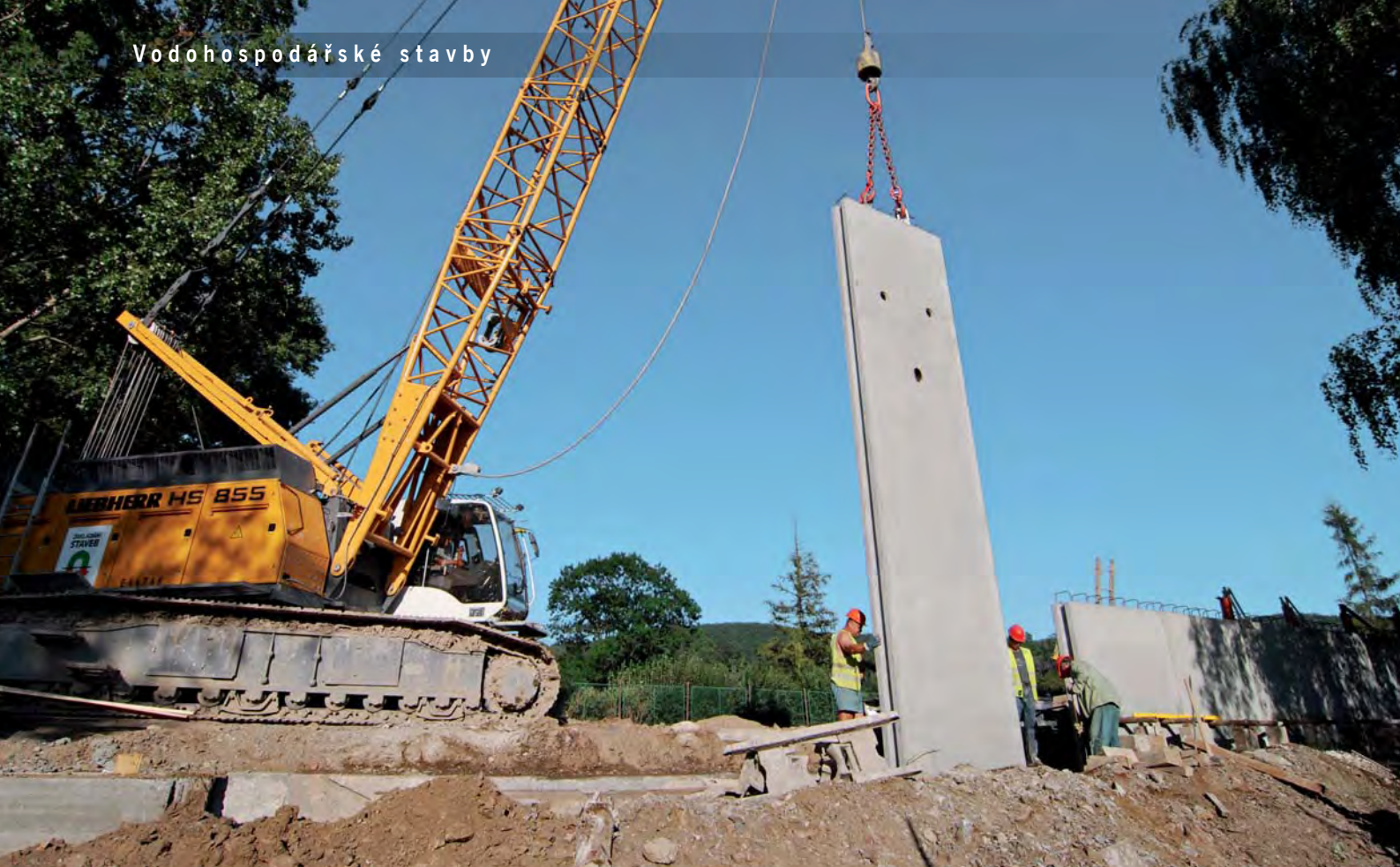
Budování prefabrikované podzemní stěny v části Zbraslav – jih
