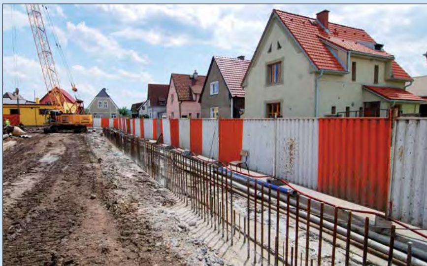
Dokončená monolitická podzemní stěna před napojením nadzemní části z žb. stěny, ulice U Jankovky v Radotíně
