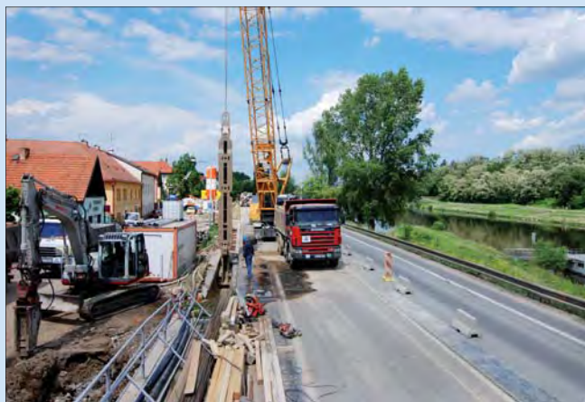
Hloubení rýhy pro osazení panelu prefabrikované stěny, Zbraslav – jih
