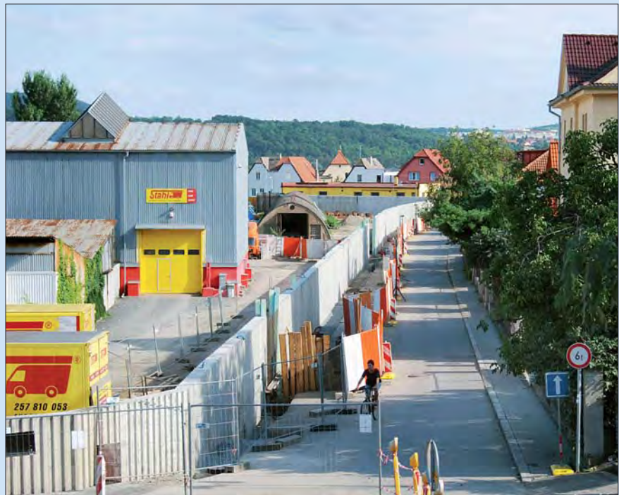
Protipovodňová stěna před dokončením, ulice U Jankovky, Radotín
