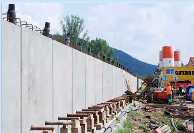
Prefabrikovaná podzemní stěna během osazování tahových mikropilot
