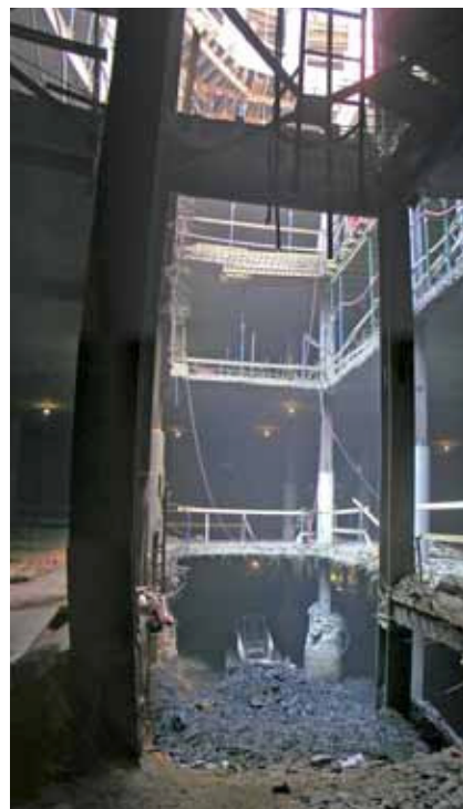
Ponechaný otvor ve stropních deskách pro těžbu zeminy umožnil nevědní pohled na pět rozestavěných stropních desek
