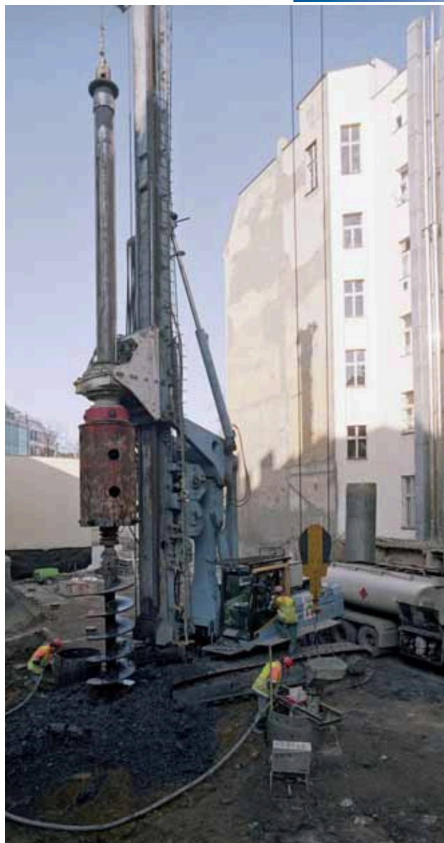
Vrtná souprava při hloubení vrtů průměru 1200 mm pro osazení ocelového sloupu
