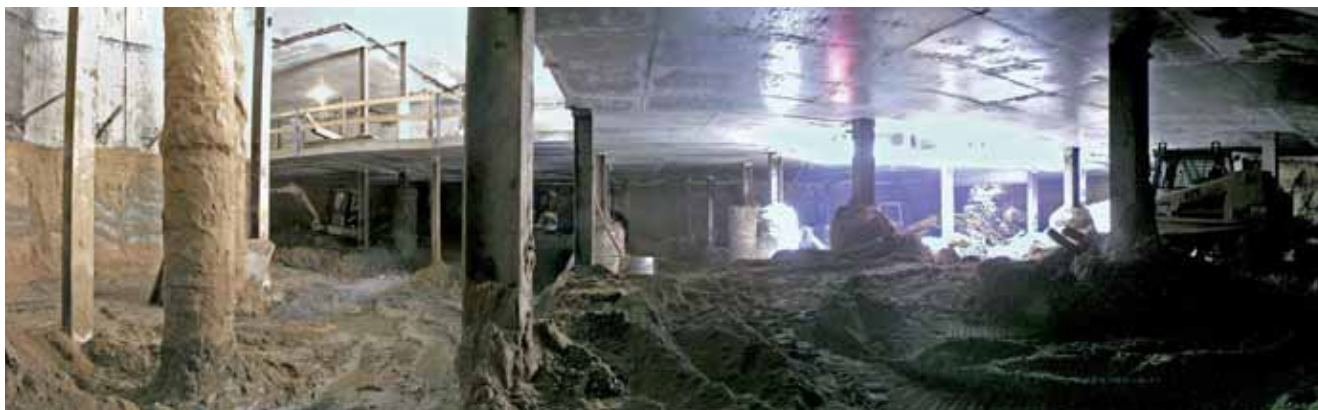
Panoramatický pohled v úrovni suterénu 4. PP. Vidíme zde betonové piloty prům. 600 mm pro založení jeřábu a definitivní ocelové sloupy s obnaženými hlavami základových pilot (vzadu).
