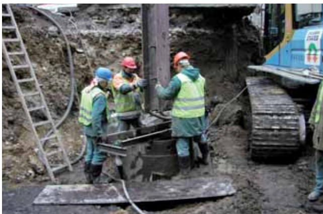
Osazování ocelového HEB sloupu do vrtu a jeho následné přesné usazení pomocí odnímatelného nástavce s kardanovou hlavou
