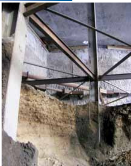
Po betonáži stropu v úrovni 1. PP byl postupně odtěžen vnitřní prostor suterénu až do úrovně 3. PP
