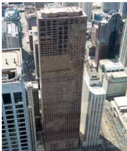
Olympia-Center v Chicagu byl založen rovněž metodou Top & Down
