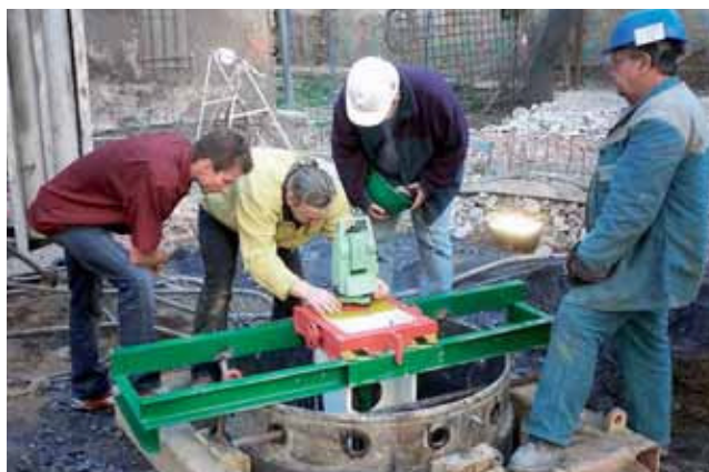
Osazování ocelového HEB sloupu do vrtu a jeho následné přesné usazení pomocí odnímatelného nástavce s kardanovou hlavou
