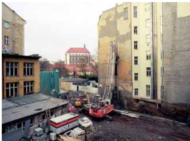
Hloubení monolitických podzemních konstrukčních stěn
