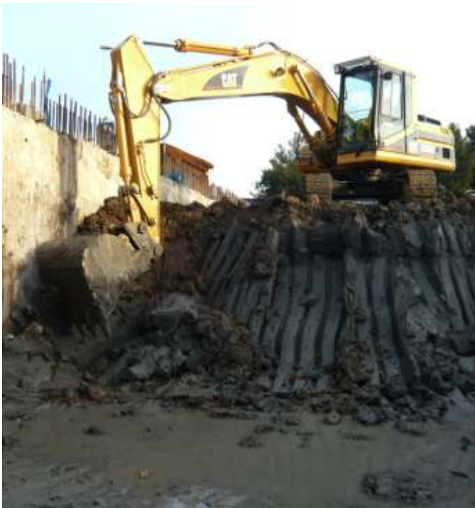
Výkop stavební jámy na úroveň -3,40 m
