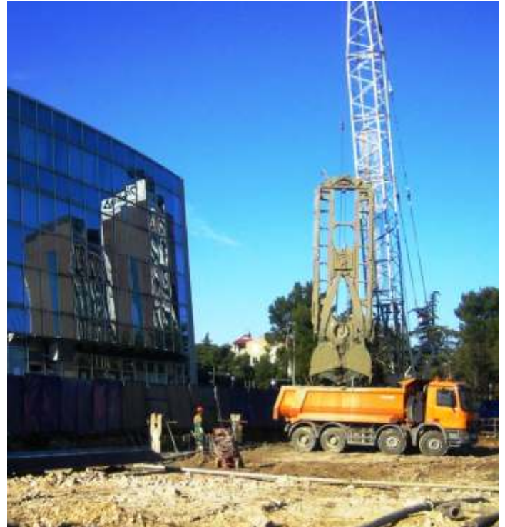
Hloubení podzemní stěny v plastickém černém jílu
