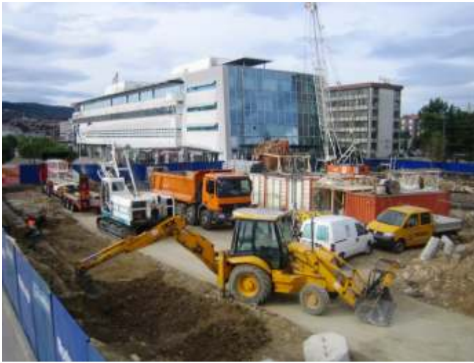
Zahájení stavby, kompletace výrobní suspenze a těžké mechanizace.
