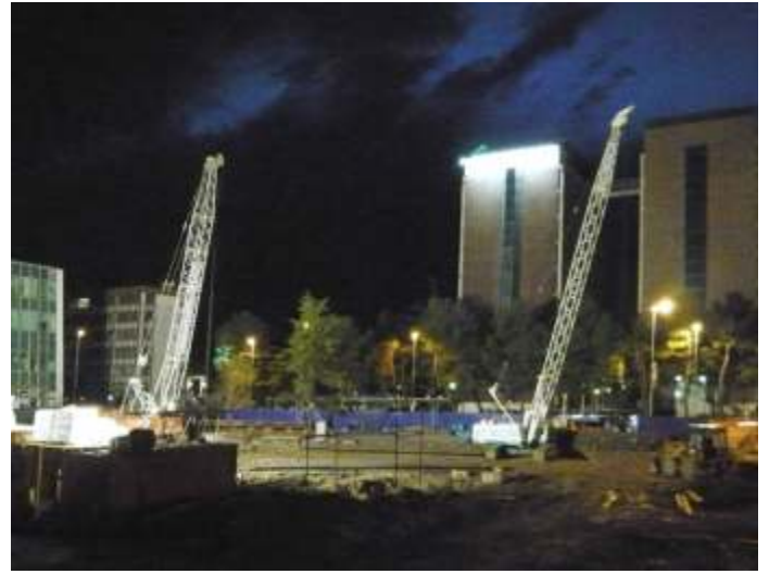
Těžba podzemních stěn v nočních hodinách
