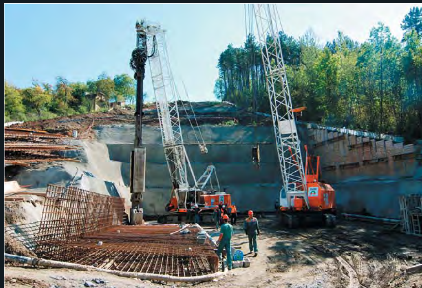
Hloubení lamel krabicového založení podpěry P3
