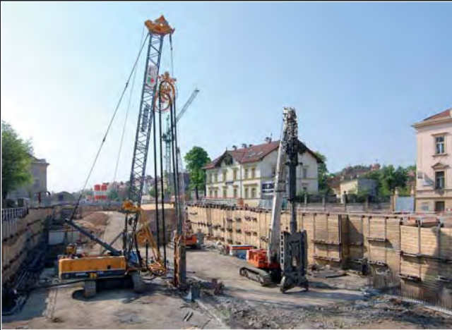
Realizace konstrukčních podzemních stěn z úrovně zapaženého předvýkopu v pohledu od Letné směrem ke Špejcharu
