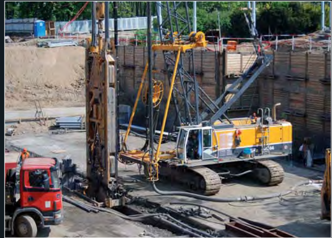
Detailní záběr na hydrofrézu při těžbě lamely podzemní stěny
