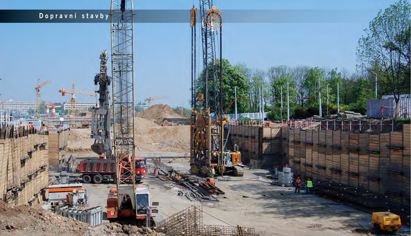
Stavební jáma pro výstavbu dilatací 9, 10, 11, realizovaných v konstrukčních podzemních stěnách, zajištěná kotveným záporovým pažením během těžby podzemních stěn.
