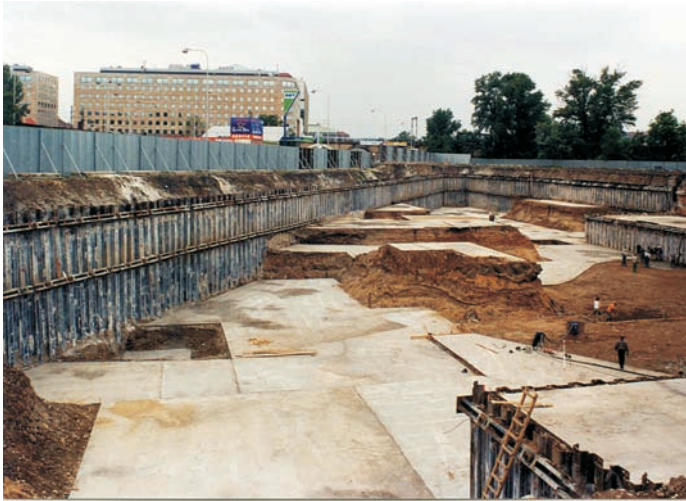
Kotvená štetovnicová stěna vkladaná do tesnicí podzemní stěny ze samotvrdnoucí suspenze
