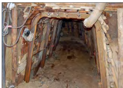
Ražená štola pro přeložení kanalizace pod ještě nevykopenými pozemky budoucích tunelů
