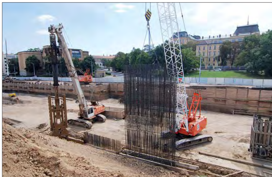
Osazování armokoše podzemní stěny do vyhloubené rýhy
