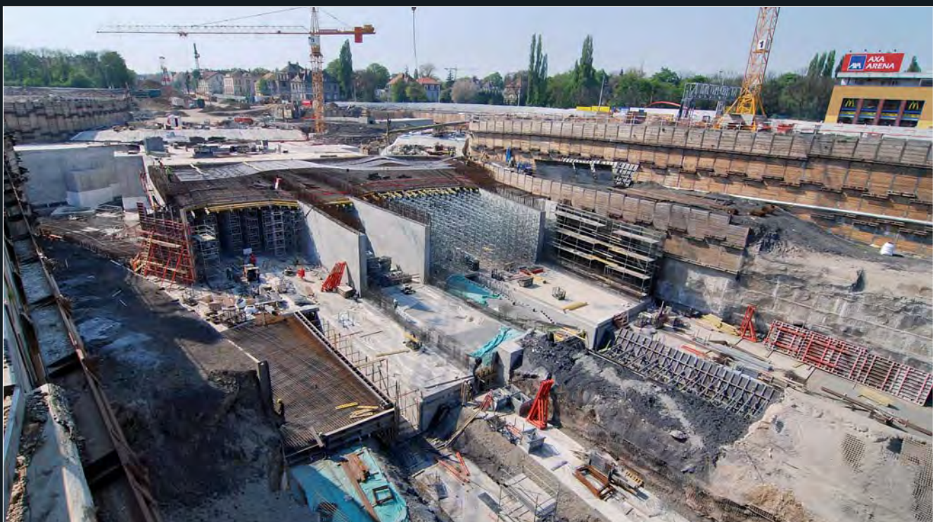
Kontinuálně probíhající výstavba tubusů budoucích tunelů od dilatace 12 směrem k budoucímu portálu raženého tunelu v zapažené stavební jámě
