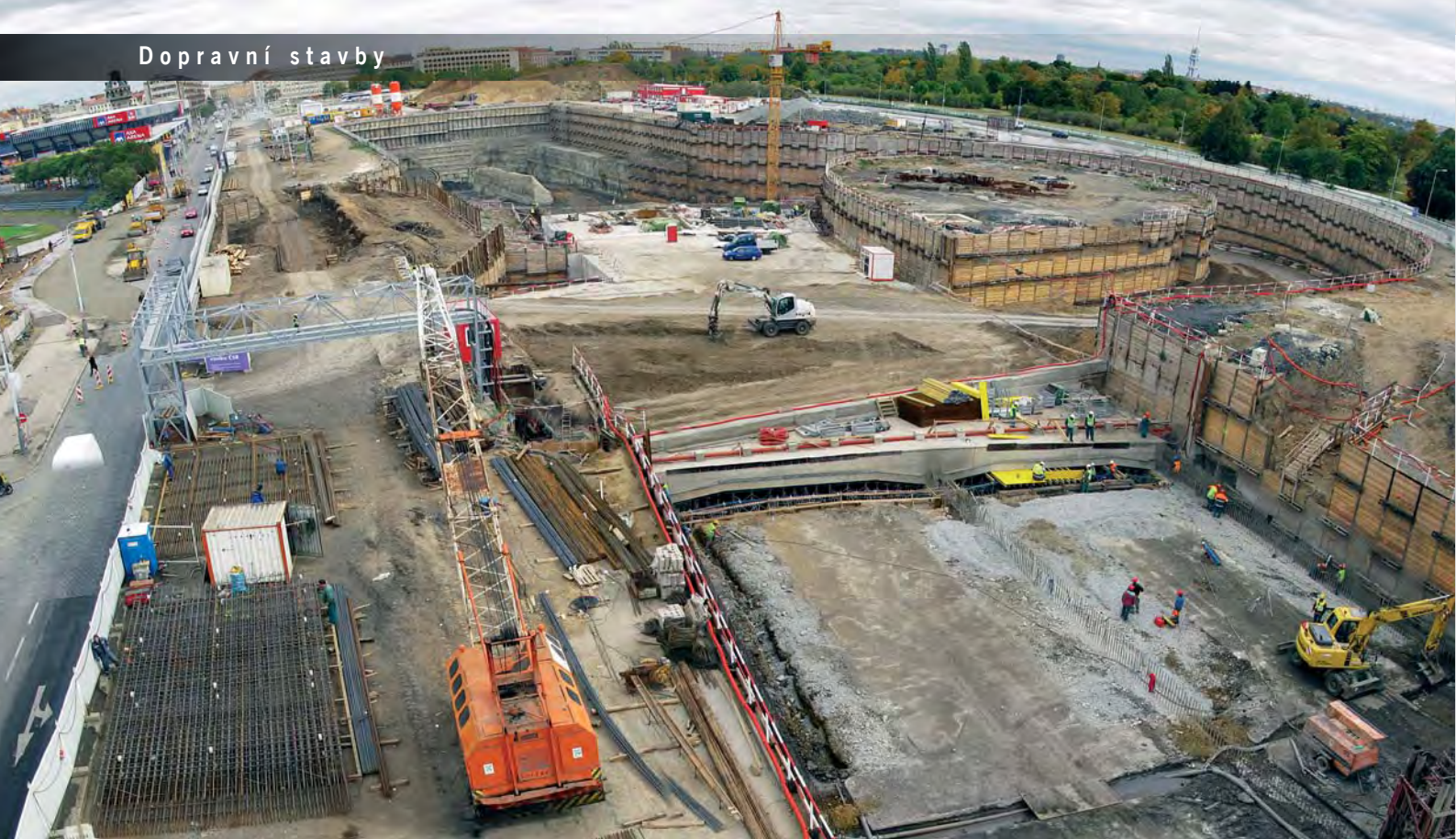
Celkový pohled na portálovou stavební jámu Letná v rámci stavby 0079 Špejchar-Pelc-Tyrolka
