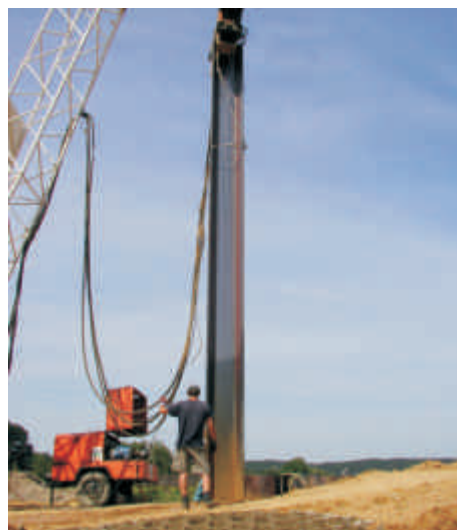
Středová těsnící clona ze štětovnic
