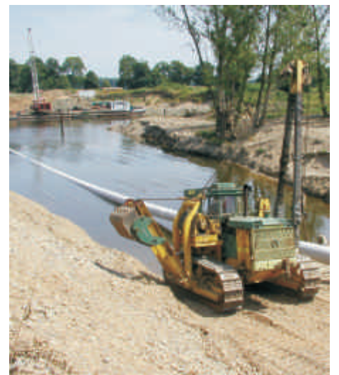
Průchod plynovodu hrází a korytem Vltavy
