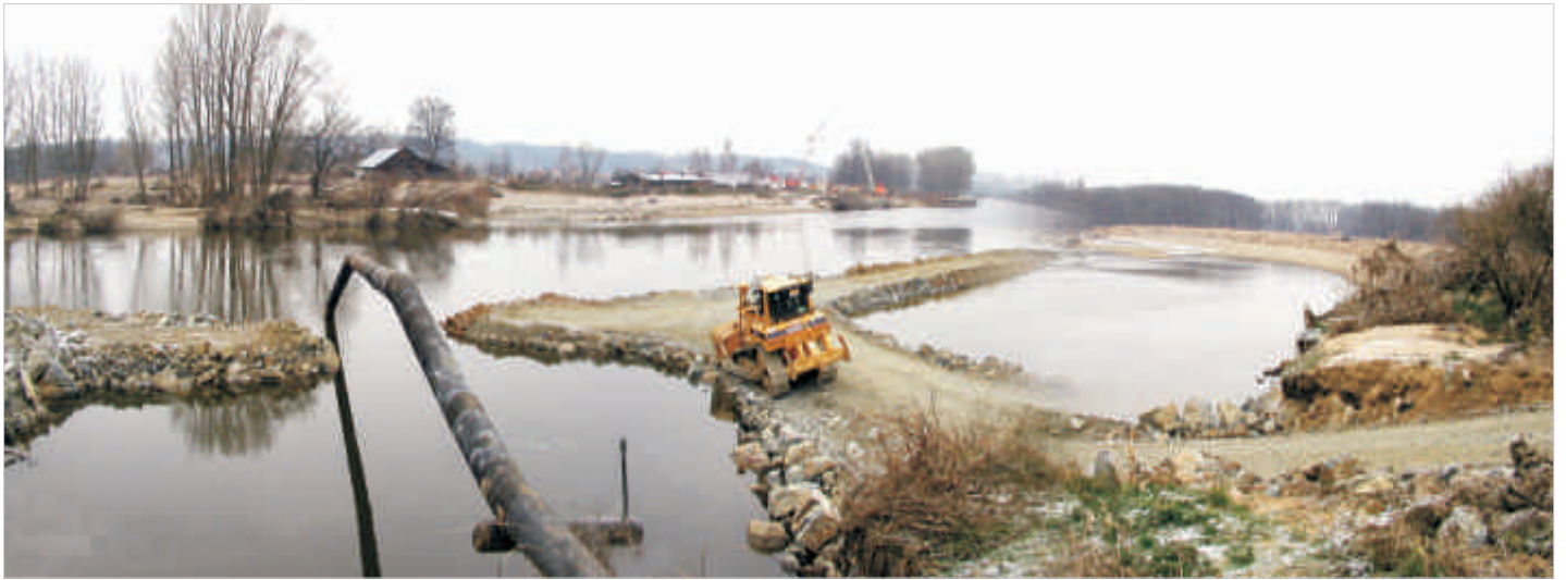
Zahájení prací na obnově povodní zničené hráze
