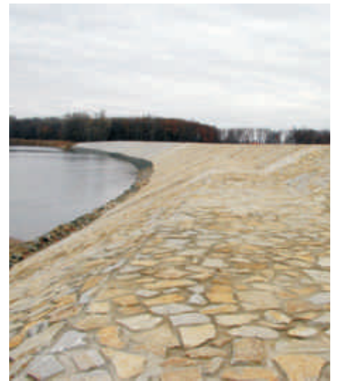
Návodní líc opevněný lomovým kamenem
