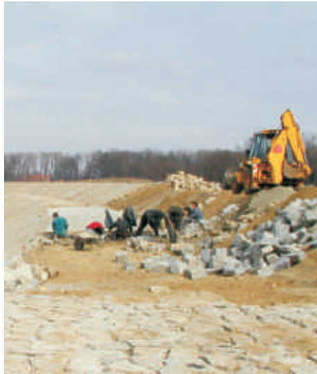
Práce s lomovým kamenem
