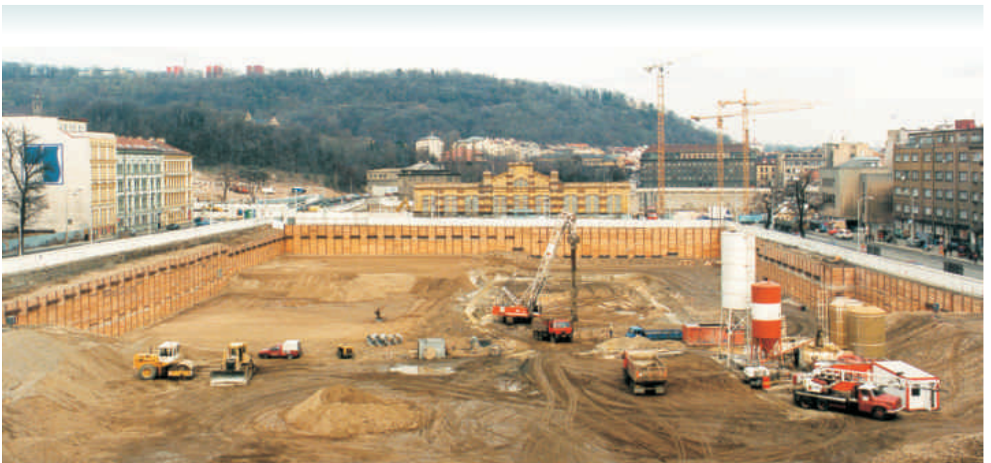
Stavební jáma Anděl Business Centra v období výkopových prací
