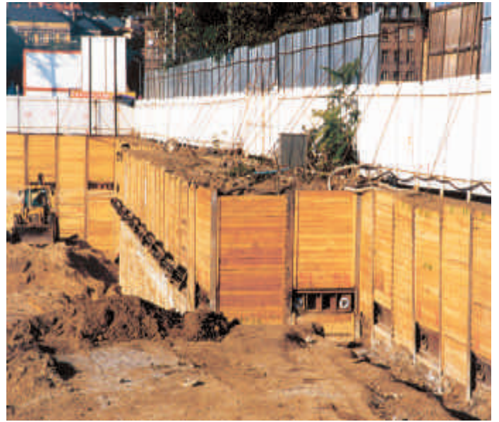
Detail pažící konstrukce
