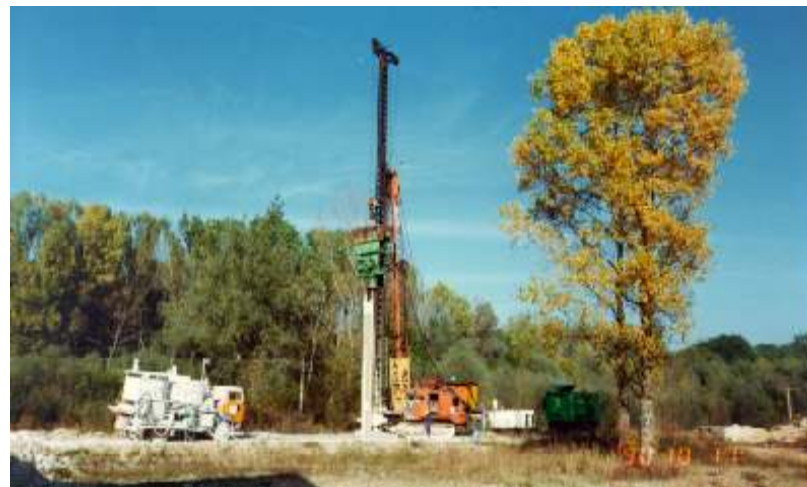
Tenká těsnicí stěna Thin cut-off walls
