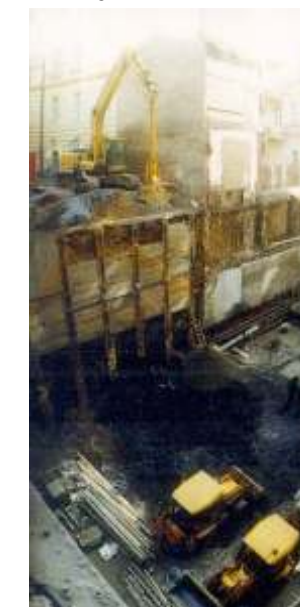
Pažení provedeno záporami ze zdvojených válcovaných U profilů Wailing construction from double U-beam and wailing from 100/8 mm pipe
